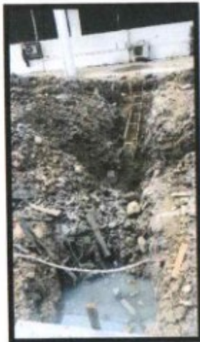
Pemasangan Bekisting Pondasi Bahu
